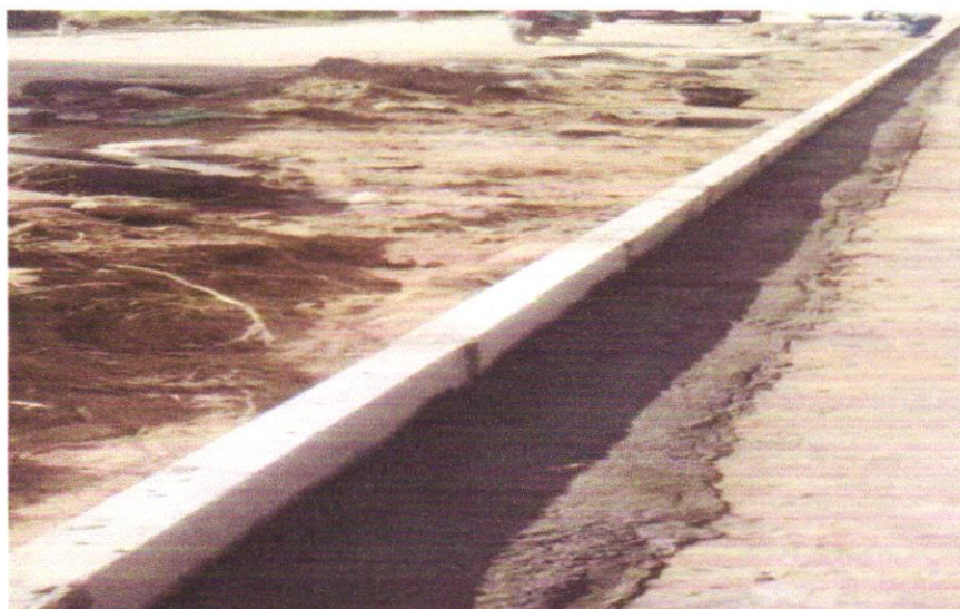
FOTO 03- ASSENTAMENTO DE GUIA (MEIO-FIO) EM TRECHO RETO, CONFECCIONADA EM CONCRETO PRÉ-FABRICADO, DIMENSÕES 100X15X13X20 CM
