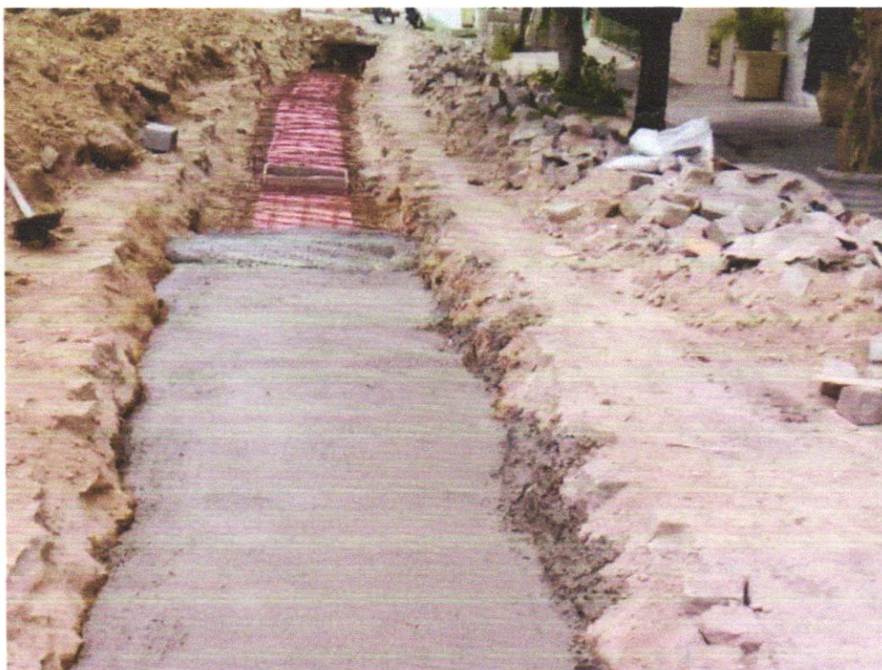
FOTO 05 – PAVIMENTAÇÃO EM CONCRETO, COM ESPESSURA DE 7 CM, COM ACABAMENTO FEITO UTILIZANDO ALISADORA DE CONCRETO (HELICOPTERO),
