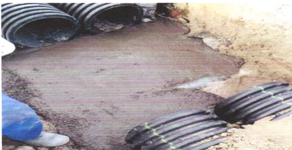
FOTO 01 – LASTRO DE CONCRETO, E=5CM, PREPARO MECÂNICO, INCLUSOS LANCAMENTO E ADENSAMENTO
