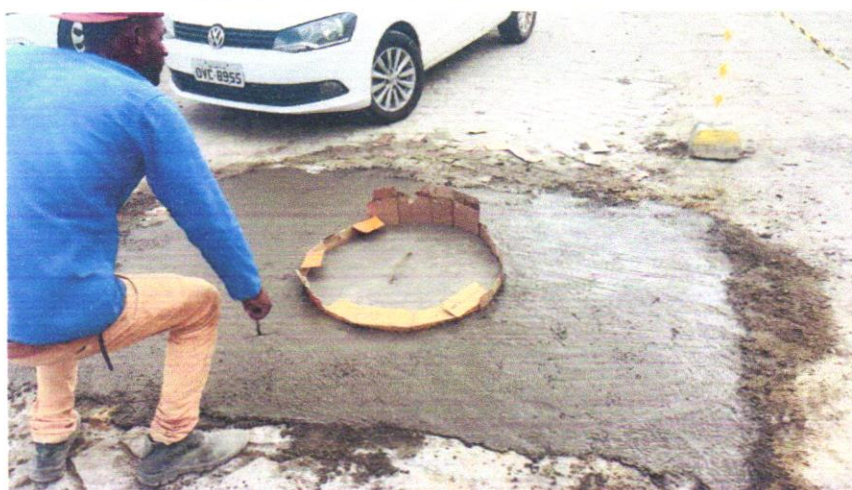
FOTO 02 – PAVIMENTAÇÃO EM CONCRETO, COM ESPESSURA DE 7 CM, COM ACABAMENTO FEITO UTILIZANDO ALISADORA DE CONCRETO (HELICOPTERO)
